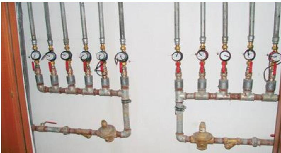
Рисунок 4 – счетчики горячей и холодной воды.
