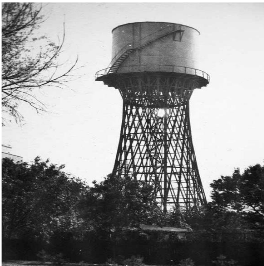
Рисунок 3 – Водонапорная башня системы Шухова в Краснодаре в период эксплуатации с баком для воды емкостью 60 000 ведер [1].
