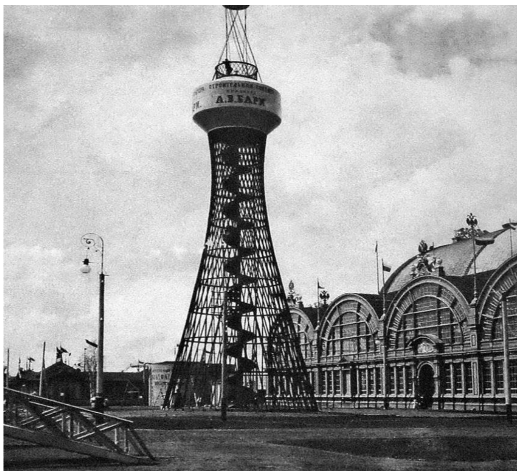
Рисунок 2 – Первая в мире гиперboloидная водонапорная башня системы Шухова и павильон Машинного отдела с арочным покрытием системы Шухова на выставке в Нижнем Новгороде, 1896
