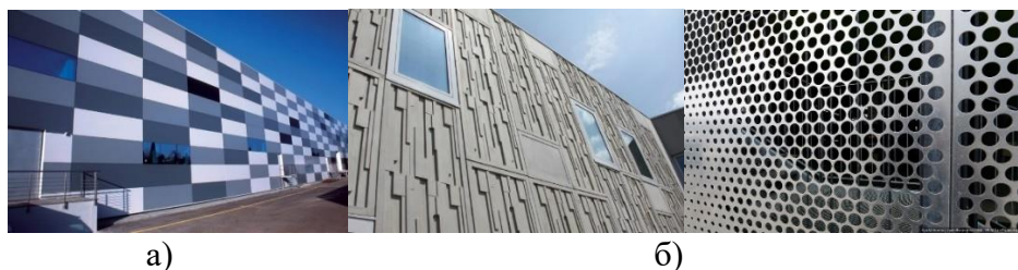
Рисунок 5 – Облицовочные панели: а – металлокерамические; б – фактурные
