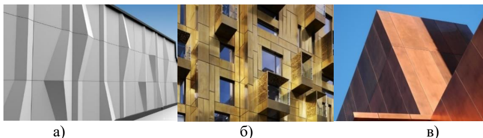
Рисунок 3 – Облицовочные панели: а – алюминий; б – латунь; в – медь
