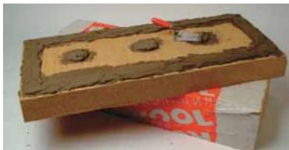
Рис. 2. Нанесение клеевого состава на плиту
