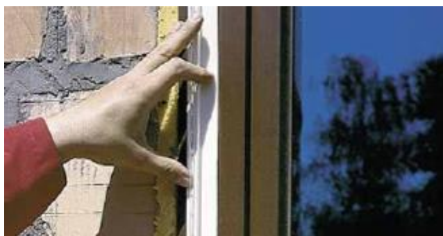
Рис. 3. Монтаж профиля примыкания
