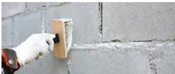
Рис. 11. Очистка поверхности от загрязнений
