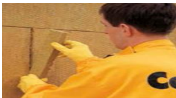
Рис. 9. Заделка щелей
