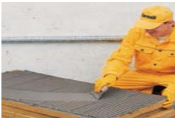
Рис. 8. Сплошной метод монтажа
