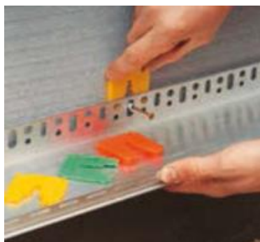
Рис. 6. Монтаж прокладок в местах ям
