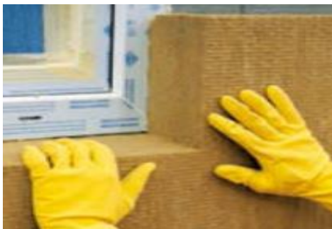
Рис. 10. Утепление откосов
