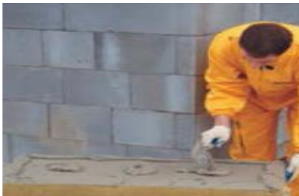
Рис. 7. Маячковый метод монтажа
