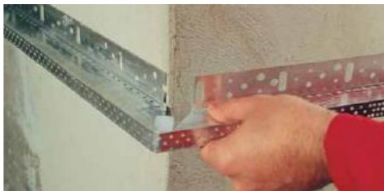
Рис. 1. Монтаж цокольного профиля на углах здания
