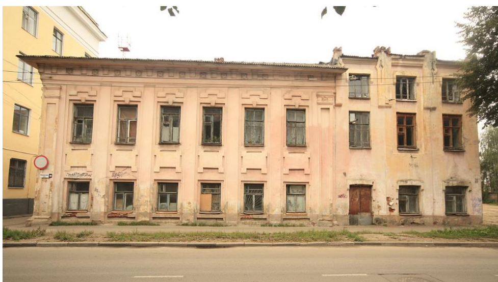
Рисунок 2 – Главный фасад по ул. Некрасова
