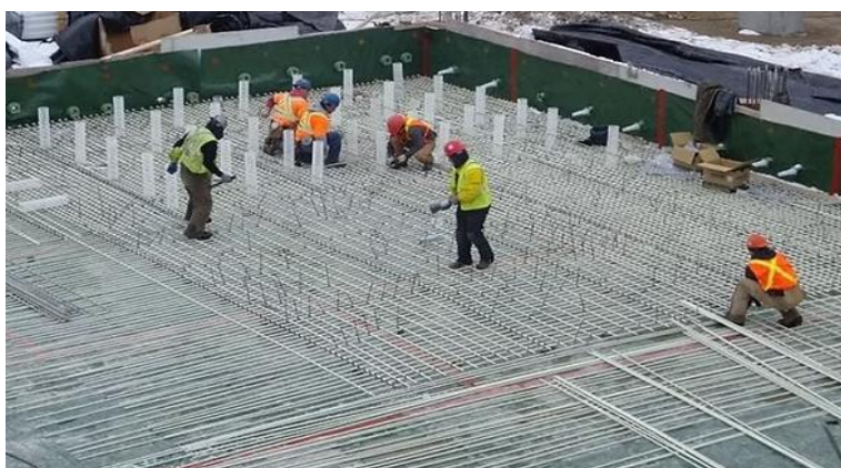
Рисунок 5 – Армирование конструкций здания Центра квантовых технологий в Ватерлоо, Канада
