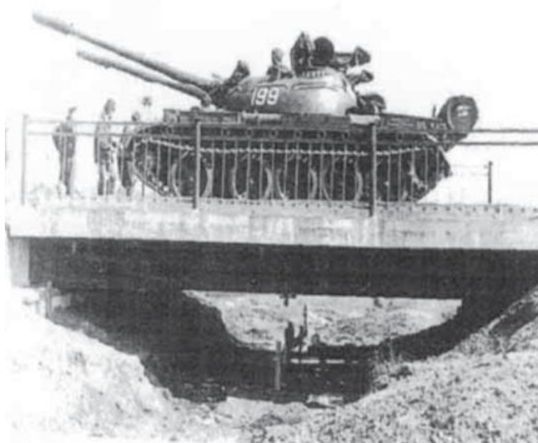
Рис. 2 – Испытания дерево-железобетонного пролетного сооружения с балками из клееной древесины, предварительно напряженными стеклопластиковой арматурой
