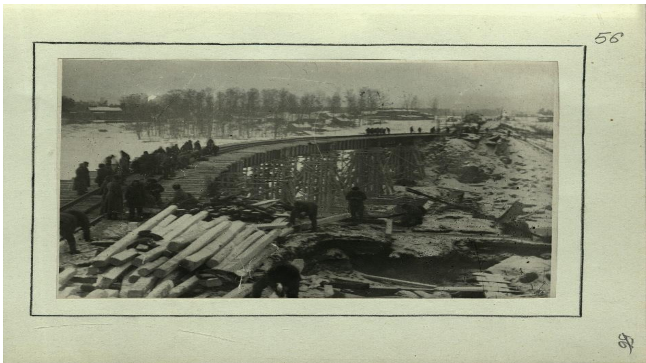
Рисунок 7. Восстановление моста через р. Луга у станции Толмачево Варшавской линии в 1944 г [3, Л. 56]
