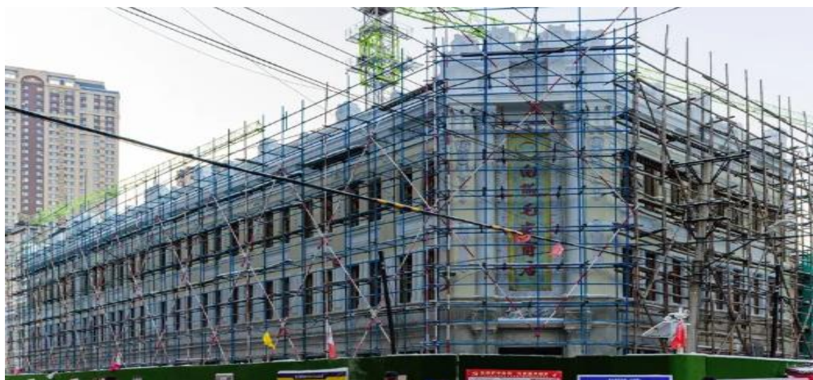
Рис. 8. Реконструкция объекта. 2024 г.
