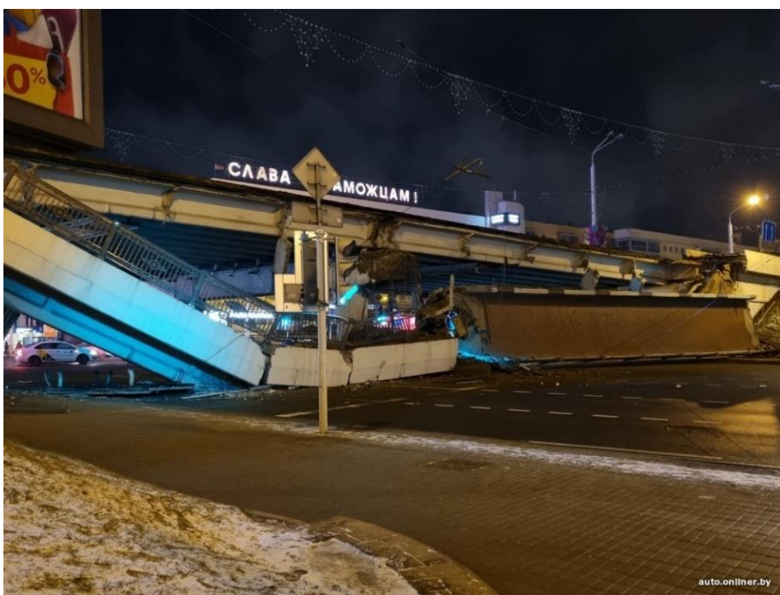
Рис.5 (Источник - https://newdeal.by/macroeconomics/2022-01-14/infrastrukturnyj-razryv-ili-mosty-v-budushhee-o-chem-zastavlyayet-zadumatsya-obrushenie-mosta-na-nemige/ ) – Обрушение балок путепровода в Минске
