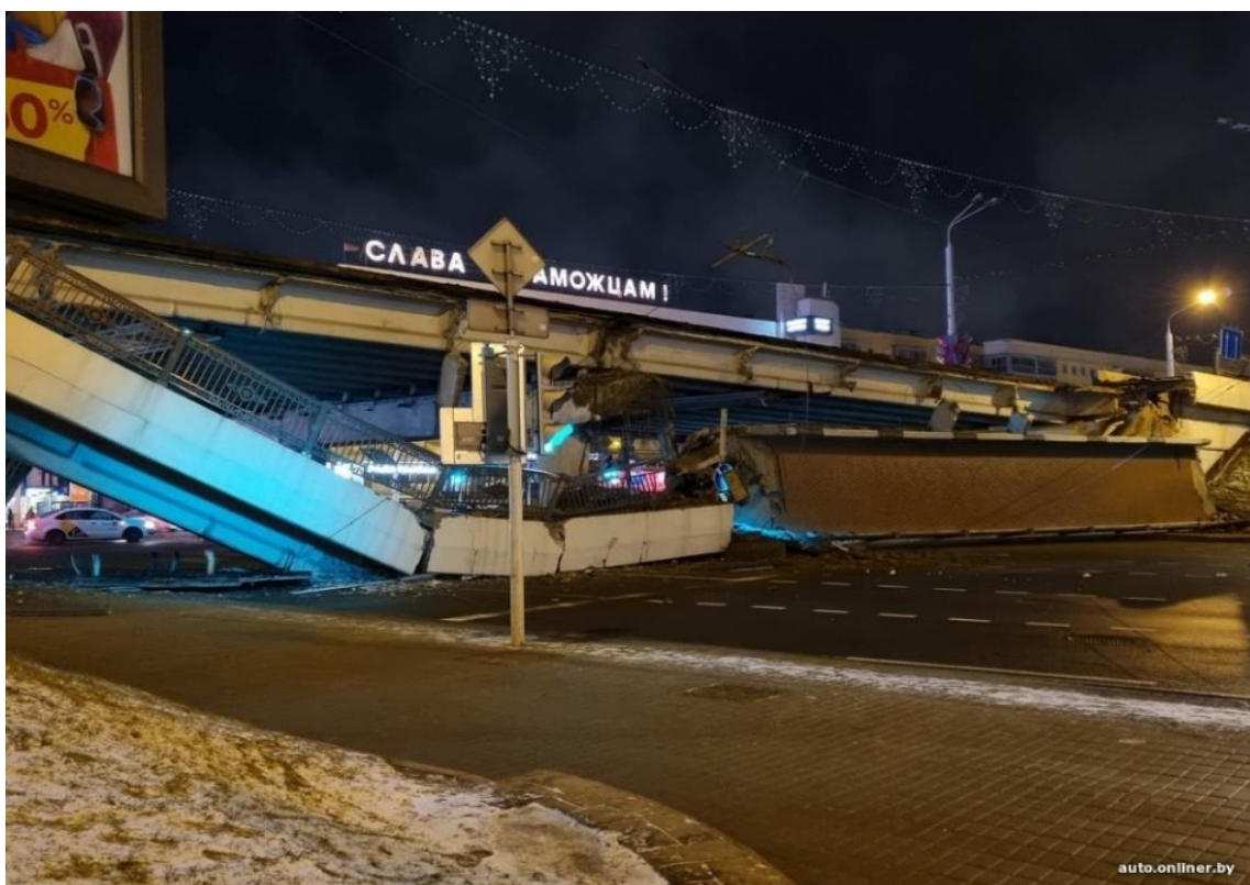
Рис.5 (Источник – https://newdeal.by/macroeconomics/2022-01-14/infrastrukturnyj-razryv-ili-mosty-v-budushhee-o-chem-zastavlyayet-zadumatsya-obrushenie-mosta-na-nemige/ ) – Обрушение балок путепровода в Минске
