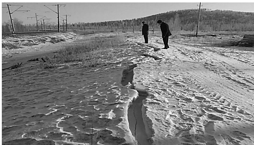
Рис. 1 – Бугор наледи вдоль насыпи железной дороги (высота 2,5 м, март 2014 г.)
